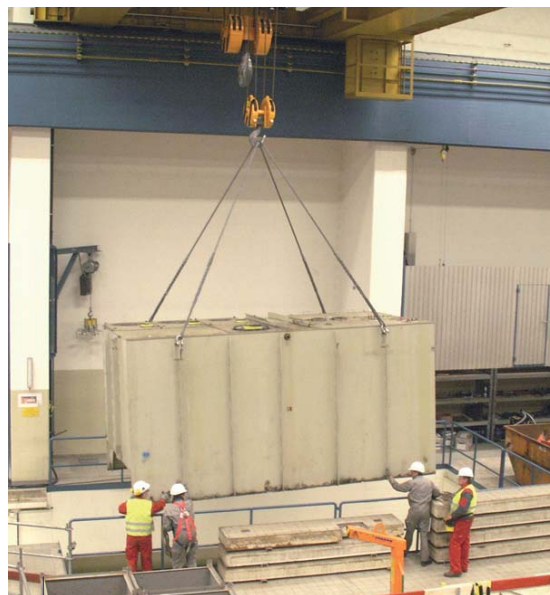
Den Ausbau und Abtransport des Turbinenölbehälters hatten die Projektgenieure des KWO von langer Hand geplant.
